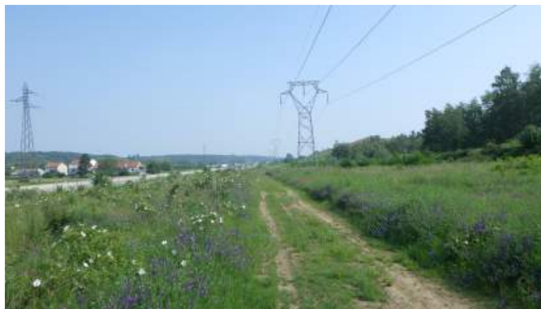
Figure 18 : Façade ouest de la zone d'étude avec le quartier de la Petite Fin de Marange-Silvange à gauche
