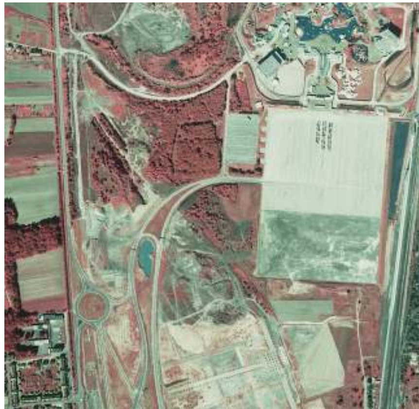
Figure 22 : Prise de vue en infrarouge de l'ancienne usine d'Hagondange en partie réaménagée en 1989 mettant en évidence les boisements de plus de 30 ans. (Source : Remonter le temps, IGN)
